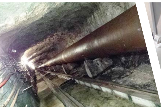
Elektrarna Rudnik mežica
